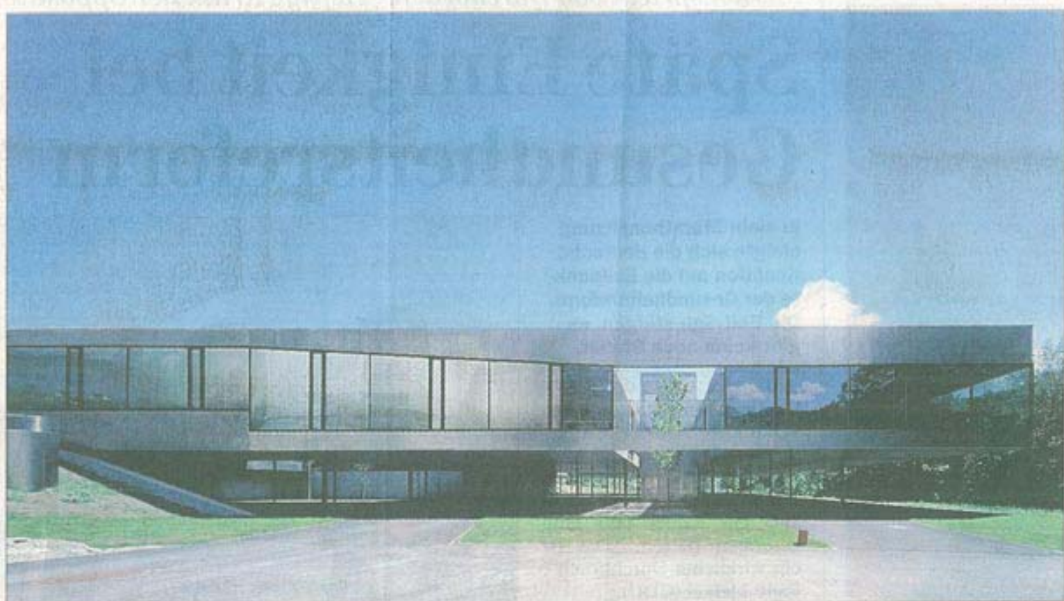
Architektur-Staatspreis für das Verwaltungsgebäude von Travel Europe in Stans.
