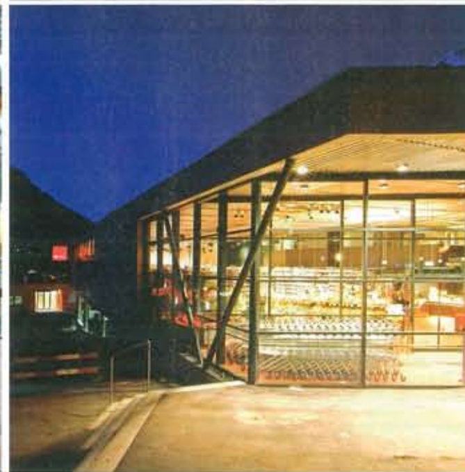
Der neue MPreis am Eingang von Sölden ist ein weiteres architektonisches Spektakel in der Firmengeschichte Architektur: Raimund Rainer
