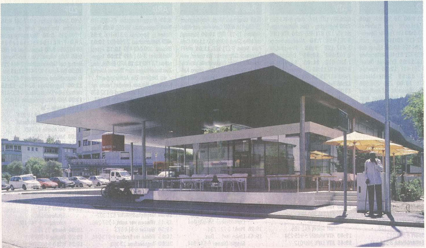
Ein Dach aus verzinktem Wellblech schwebt über dem neuen Platz zum Einkaufen bzw. Verweilen am Innsbrucker Mitterweg.
