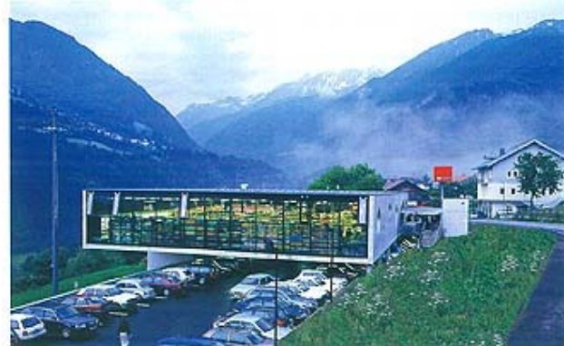
M-Preis möchte, dass sich seine Läden harmonisch in die Umgebung einfügen. Das schließt Modernität nicht aus, wie das Beispiel in Wöns zeigt.
