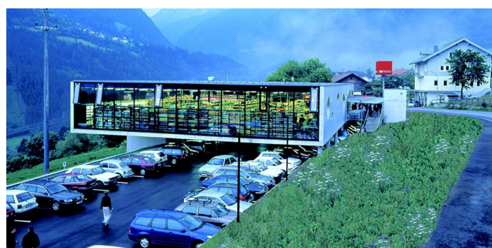
Harmonische und behutsame Bauweise verbindet Landschaft mit Supermarkt (im Bild MPREIS Wenns). Dieser Markt wurde mit vielen Architekturpreisen ausgezeichnet.
