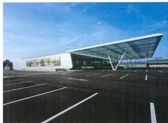
Merkur-Markt an der Wiener Brünner Straße: „Eine großzügige und ästhetische Marktplatzatmosphäre schaffen, die Kunden zu längerer Verweildauer einlädt“
