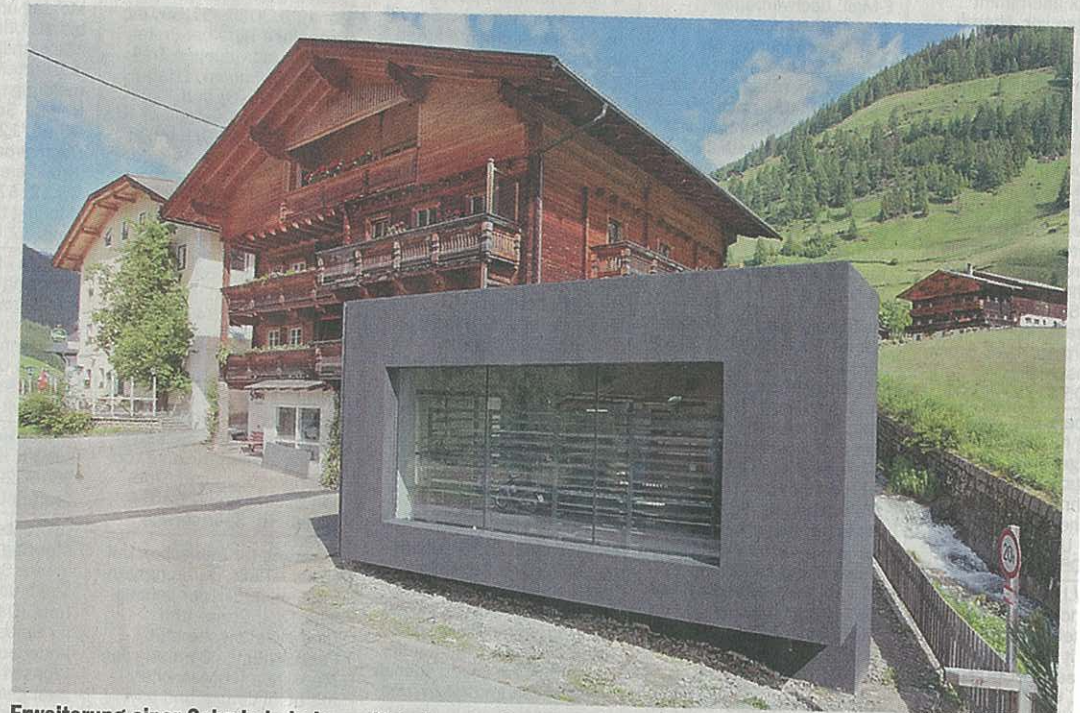
Erweiterung einer Schmiede in Innervillgraten von Architekt Peter Jungmann.
