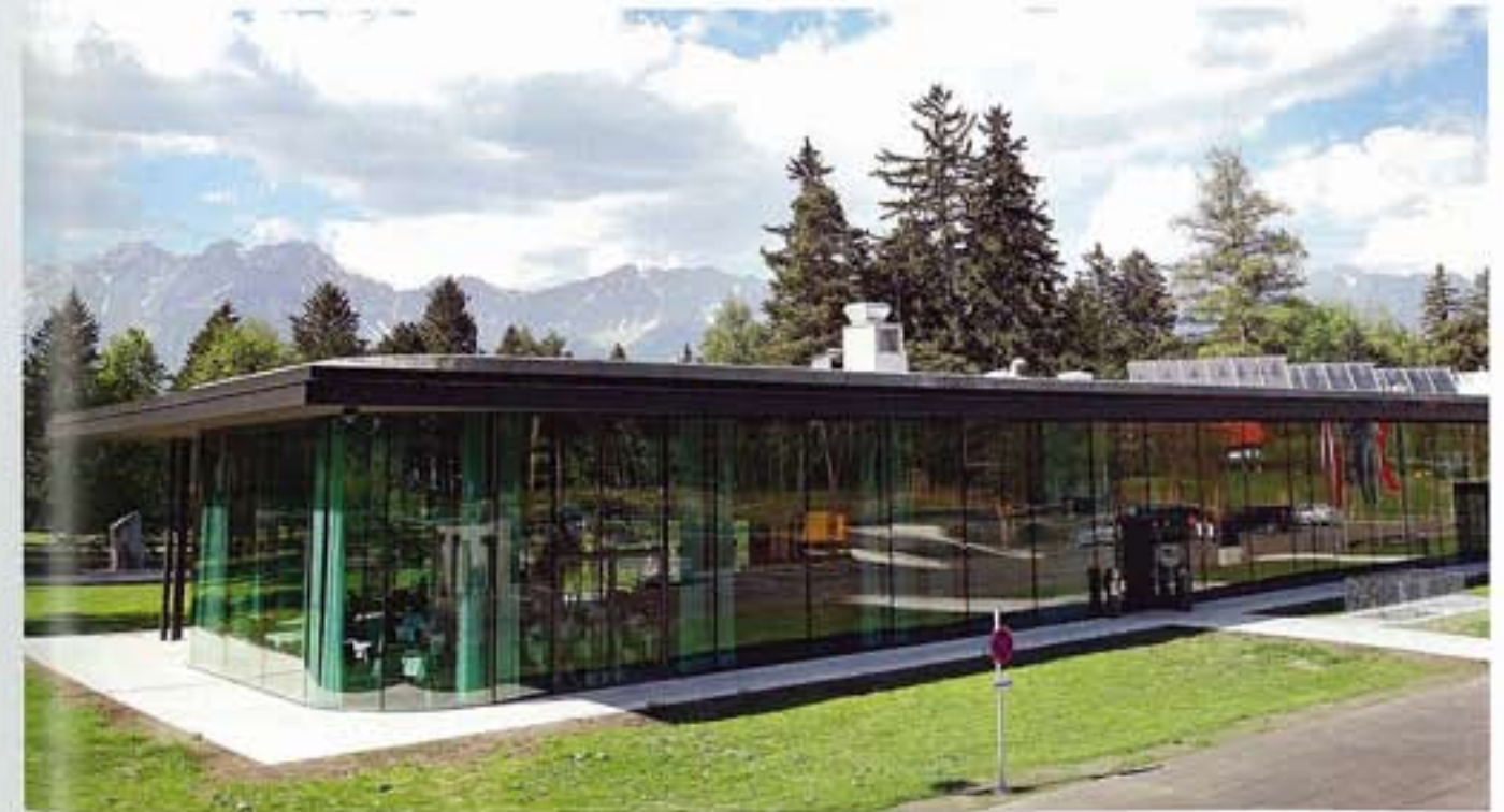
Modernisiert und völlig neu errichtet wurde das Congress Igls, der kleine Bruder des Innsbrucker Kongresszentrums in Innenstadtlage. Congress Igls, smaller brother of Innsbruck Congress Centre, has been rebuilt and modernized.
